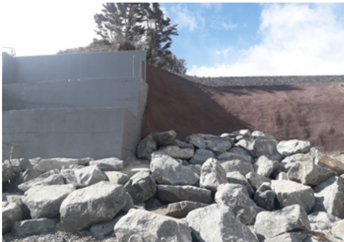
Oibreacha Cosanta Cósta ag an mBealach Isteach go dtí Trá Lána na Coirre Báine
