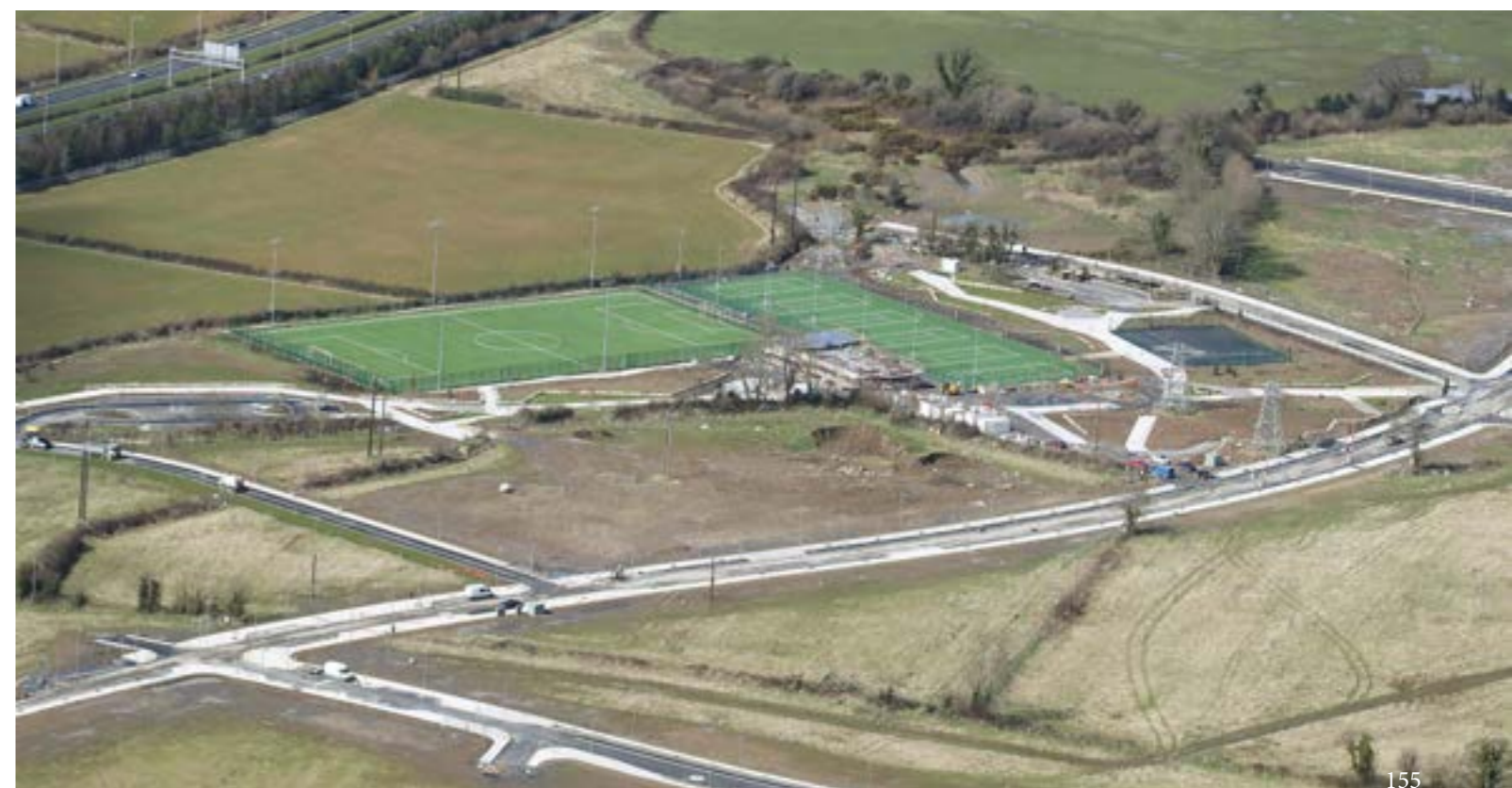
Radharc siar ón aer ar oibreacha bonneagair ag Coill na Silíní
