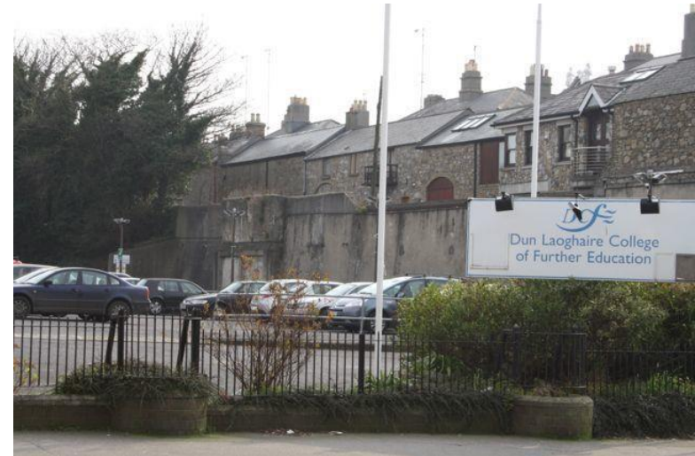
Rear roofscape De Vesce Terrace
